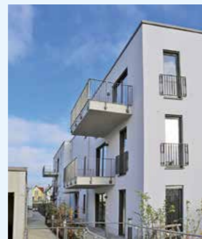
Bezugsfertig nach zwei Jahren Bauzeit: Die Wohnungen haben ein bis vier Zimmer und sind mit Holzfußböden ausgestattet
