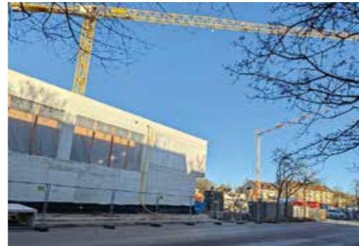
Ein Teil des Rohbaus steht: Nach anfänglichen Rückschlägen nimmt die Grundschule mit Sporthalle Gestalt an
