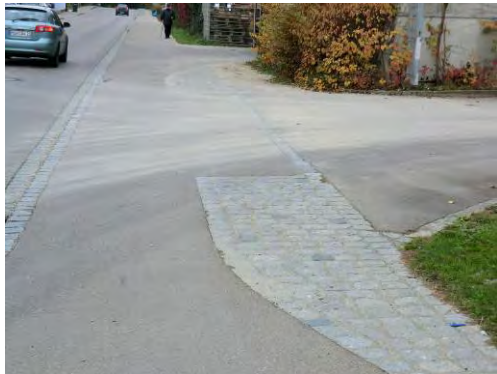
Entschärfung einer kritischen Ein- fahrtssituation durch Pflasterung (Beispiel aus Aichach)
