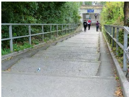
Situation am Bhf. Unterschleißheim - Nordseite
