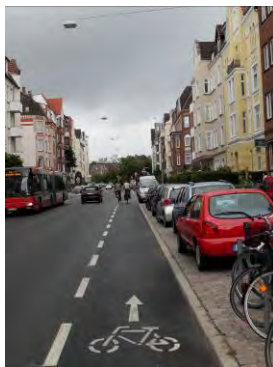
Beispiel für die Anlage eines Schutzstreifens (Kiel)
