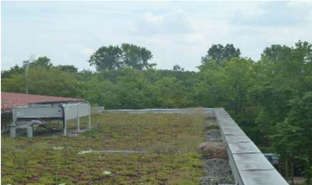
Abb. 4: Flachdachzone des eingeschossigen Anbaus an der Westseite des Lebensmittelmarktes
