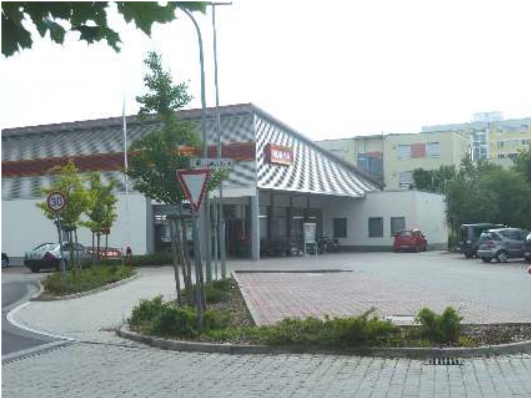
Abb. 1: Ansicht Osten Eingangsbereich Lebensmittelmarkt
