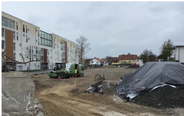
Blick von Abbruchfläche auf westlich angrenzende Häuser
