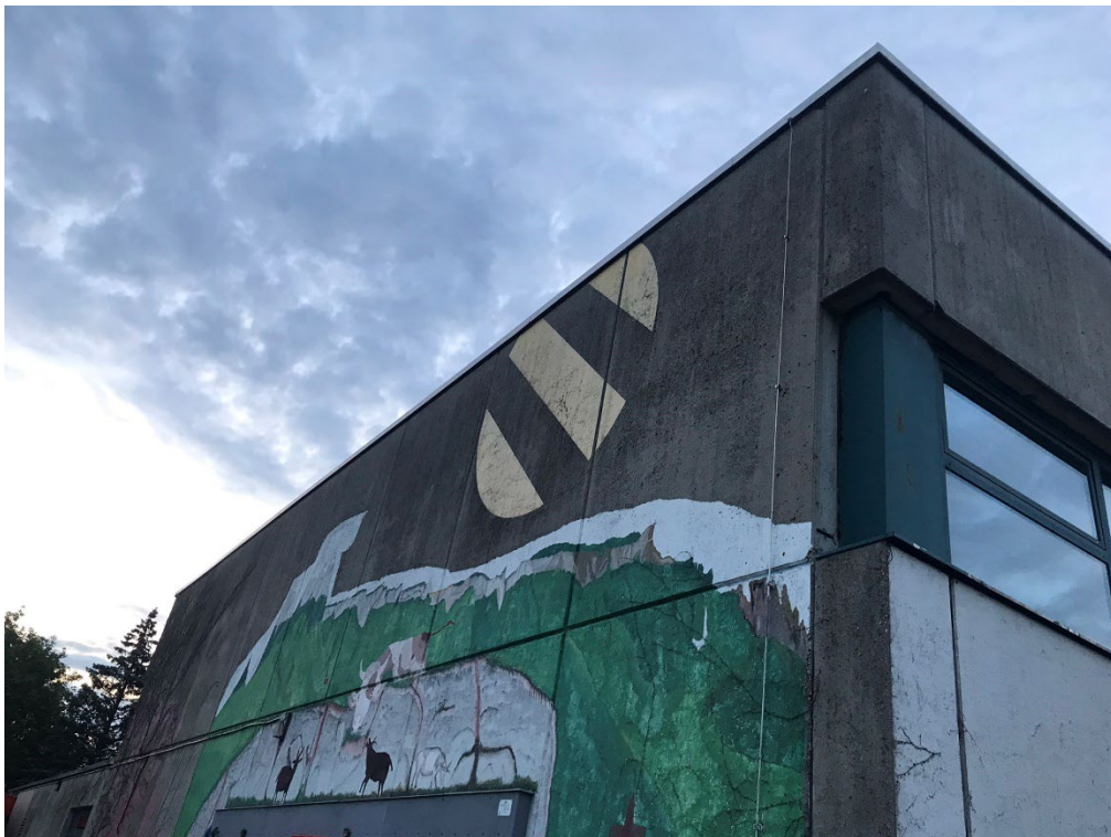
Abbildung 2: Westfassade der Turnhalle.
